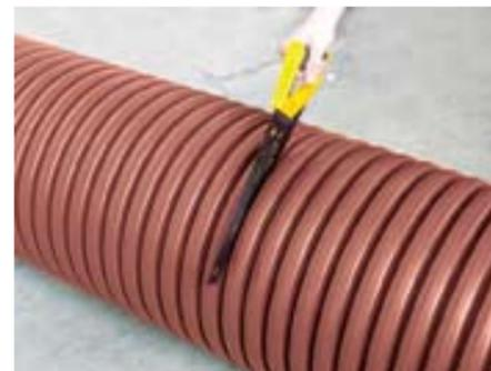
Резка трубы производится простой пилой между ребрами жесткости.
